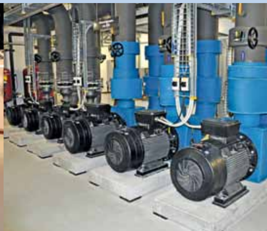
Kältepumpenanlage
