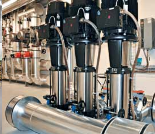
Pumpenanlage Fernwärme
